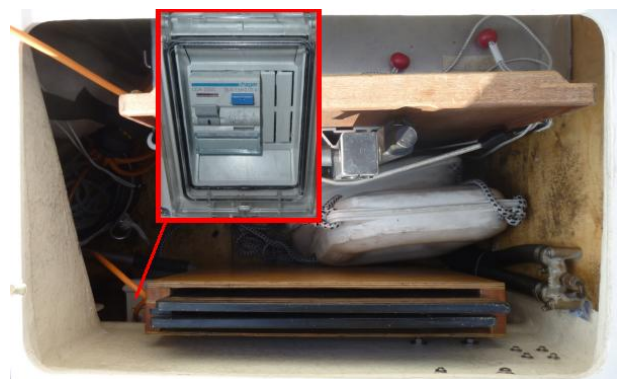
Bild 41: FI-Schutzschalter Landstrom
