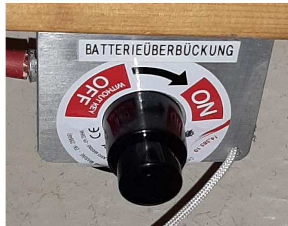
Bild 336: Batterieüberbrückung
