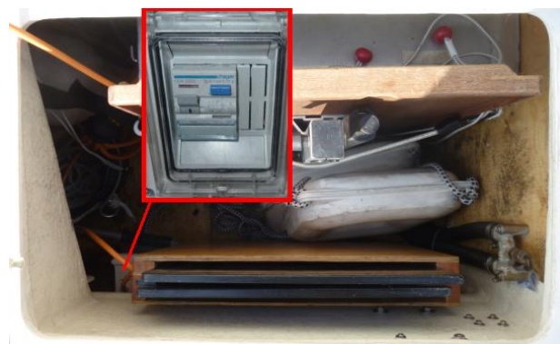
Bild 41: FI-Schutzschalter Landstrom
