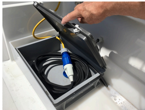
4. Kabelrest und Zwischenstecker in Rako-Kiste (so belassen)
