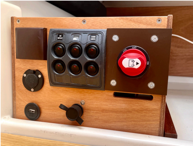
8. Front der Komfortbatteriekiste unter dem Niedergangstritt
