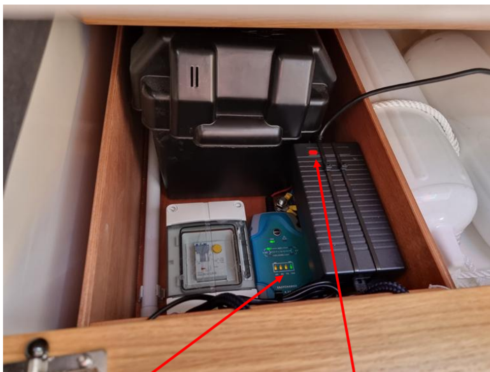
Ladegerät Bord Batterie mit Kontrolllampe und Akkustand
