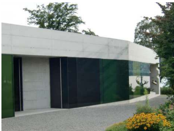
Abdankungshalle mit WC-Eingang.
